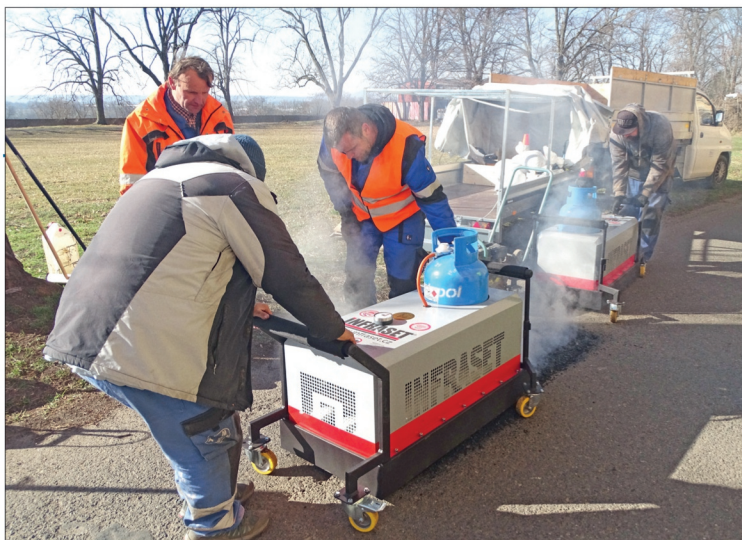
Díky speciální technologii Infraset mohou v Litoměřicích odstraňovat výtluky i v zimních měsících
